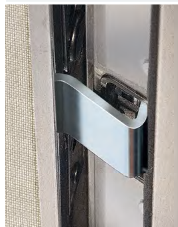
Particolare della versione HH, cerniera a scomparsa.
